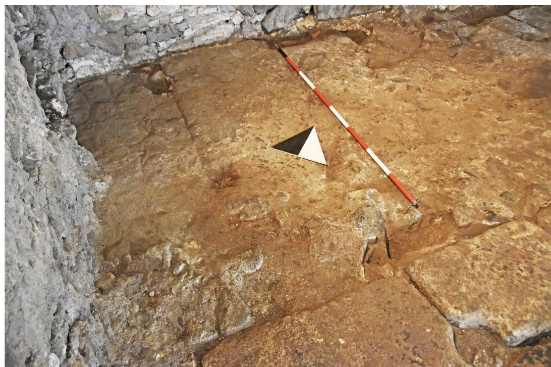
FIG. 6 Vicolo del Duomo 55, particolare della pavimentazione in lastre di tufo
