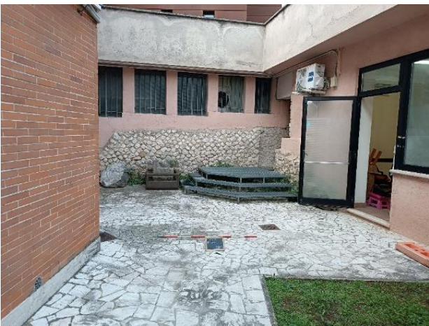
Fig. 1: inquadratura generale dell'area d'intervento prima dello scavo, vista da N-E.
